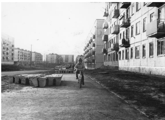
Строительство улицы Ворошилова, 1976 год
